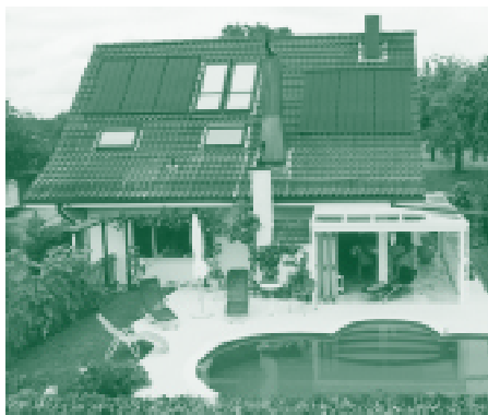
Impianto a circolazione forzata
