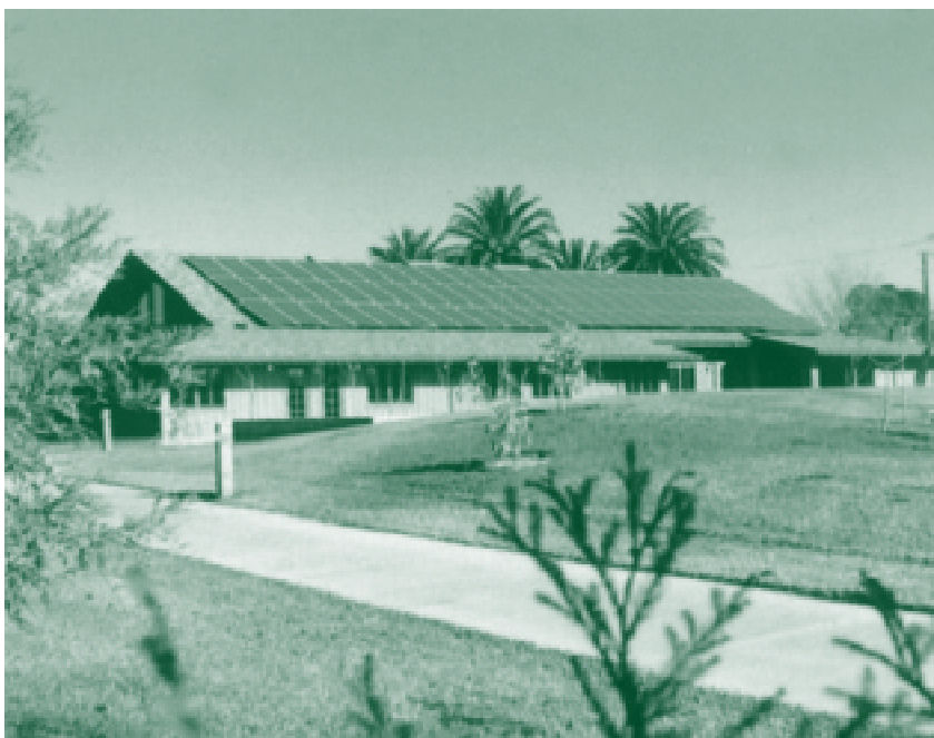
Maxi-impianto di pannelli solari
