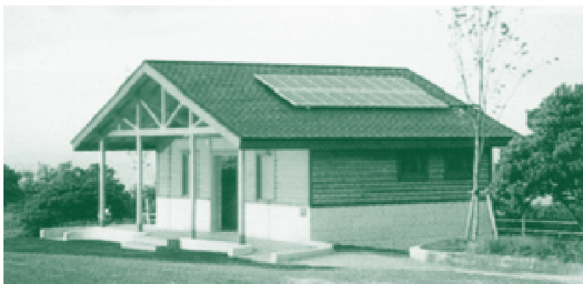
Villetta con pannelli solari
